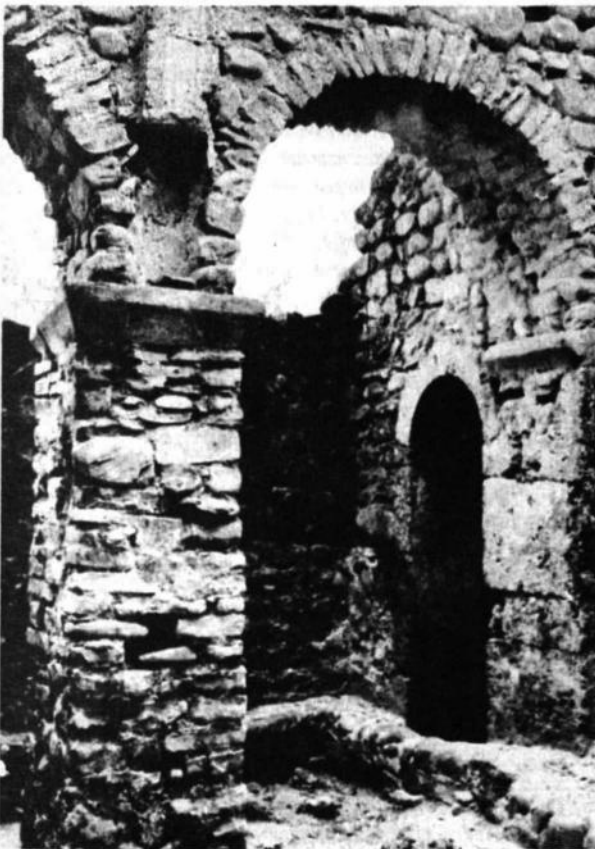
Abb. 6 Basilika in Dawati. Nordpfeiler
