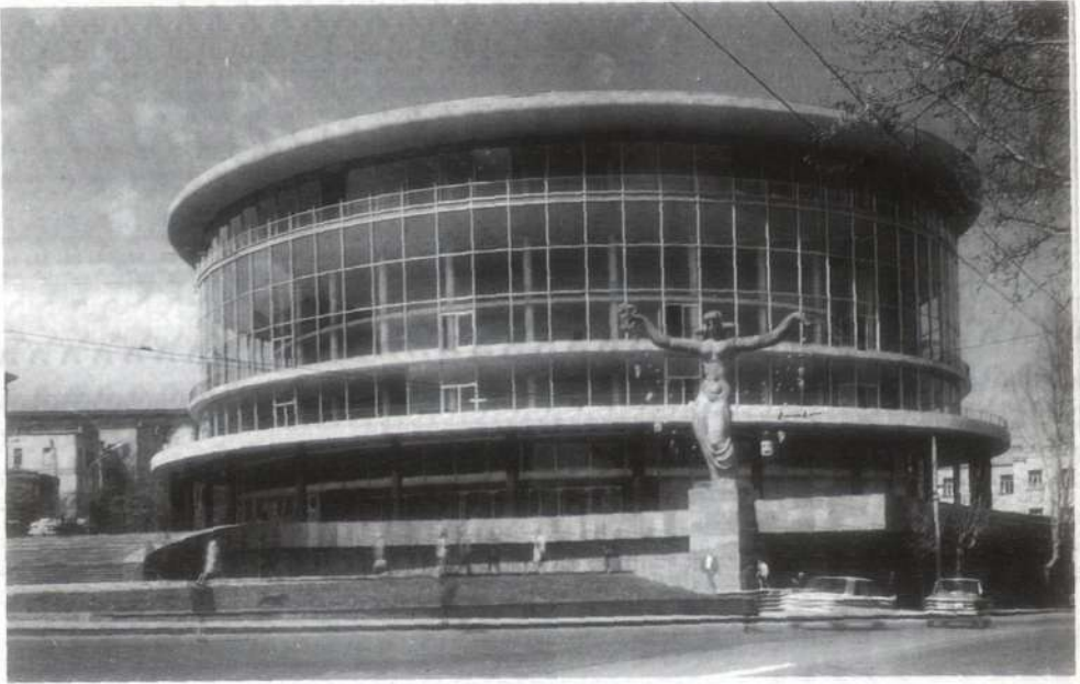
a: Gebäude der Philharmonie in Tbilisi (1971)
