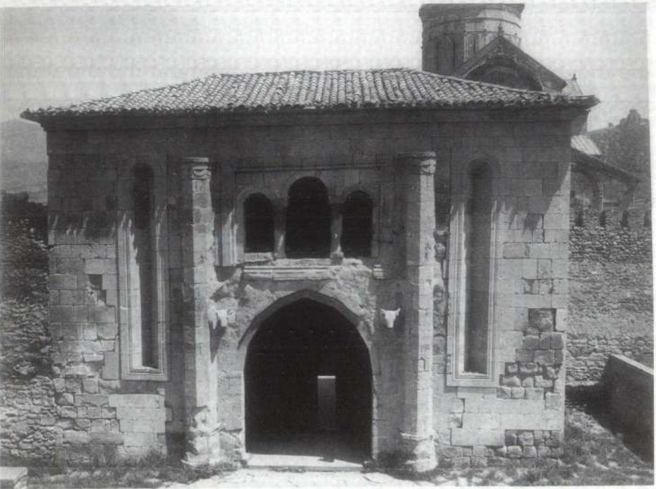
Mzcheta. Swetizchoweli, Torbau (11. Jh.), vor und nach der Restaurierung
