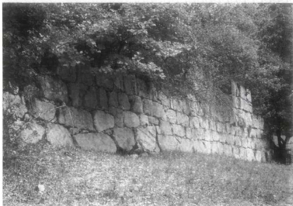
a: Südwand des Refektoriums
