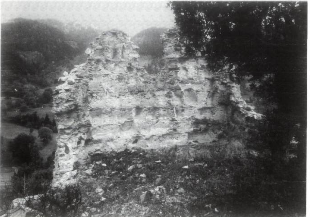
b: Şogara-Kapelle, Westmauer von Osten
